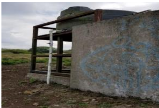
Figura 19. Pila de almacenamiento.
