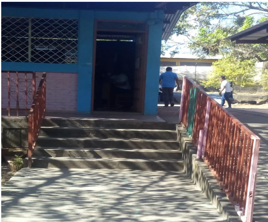
Ilustración 19, acceso al tercer pabellón del centro de frente la dirección
