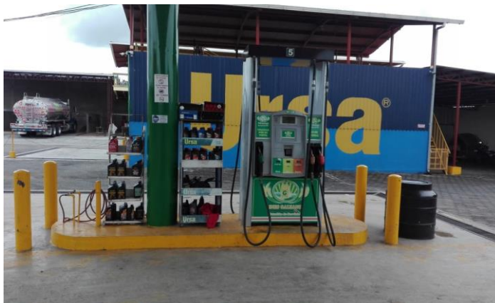
Bombas en gasolinera Inés Galeano
