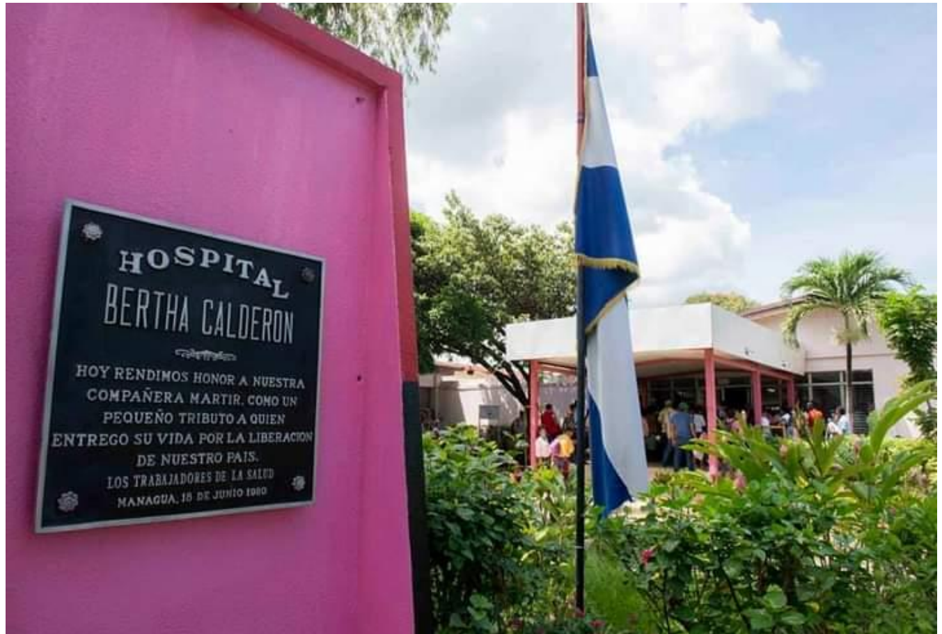
Figura No.1 Hospital Bertha Calderón Roque, Managua.
