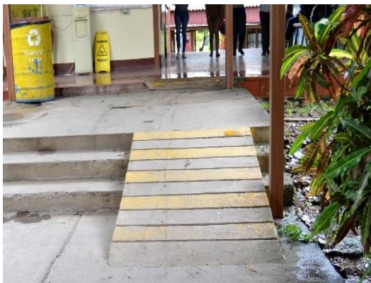
Ilustración 11. Área de acceso FAREM-Esteli
