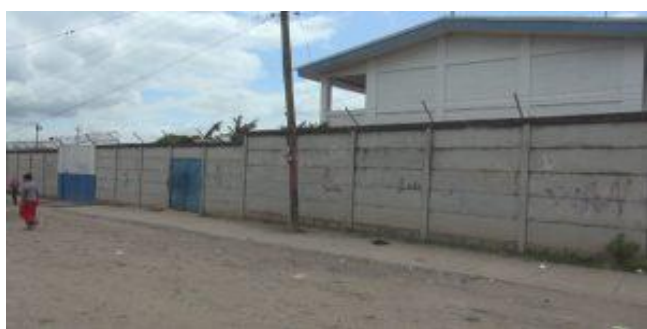
Ilustración 2 Vista externa del muro que perimetral del instituto Nacional Reino de Suecia.
