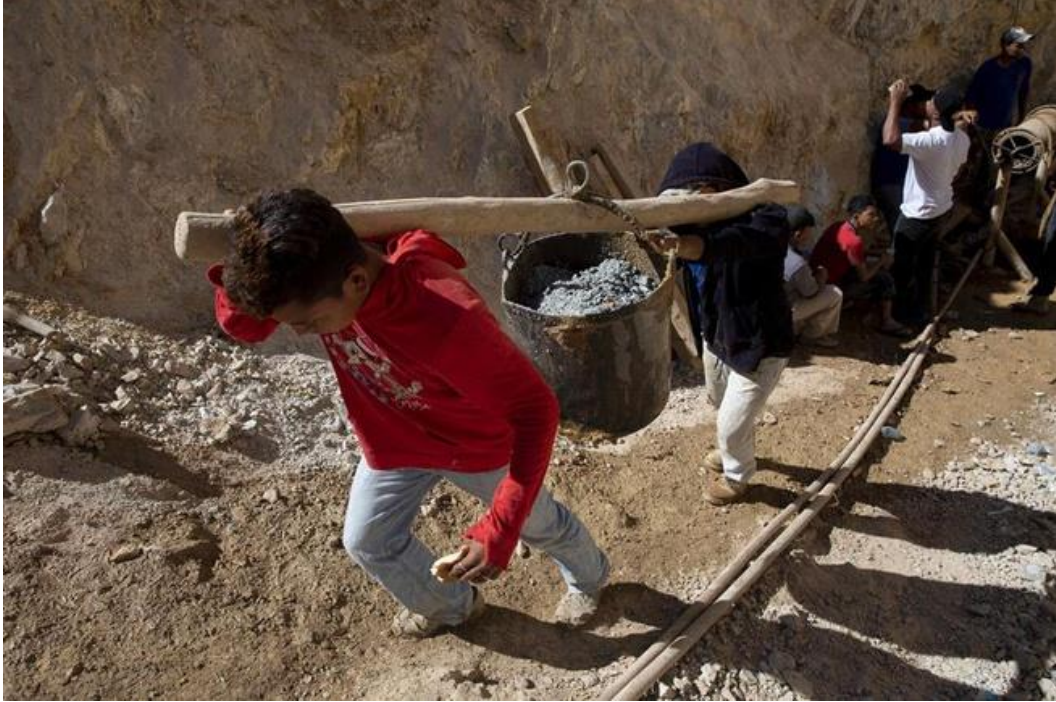
Anexo.No.5. Extracción de broza en baldes
