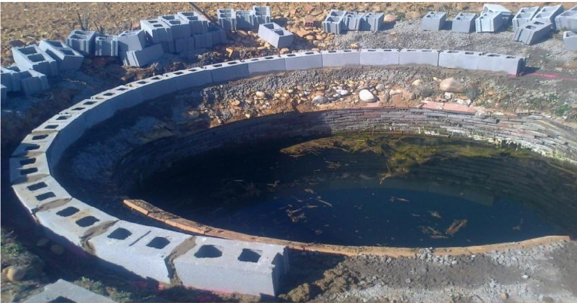
FIGURA 6. Acondicionamiento de la fuente.
