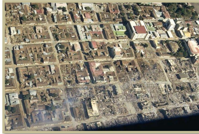
Figura 3.8. Vista aérea del centro de Managua después del terremoto de 1972. (Steinbrugge, 1972).
