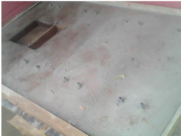
Figura 2.17 Concreto de 3000 psi en tapadera
