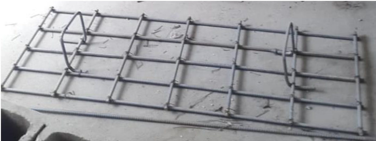
Figura 2. 15 Acero no. 3 en tapaderas (tipo 1 y 2)
