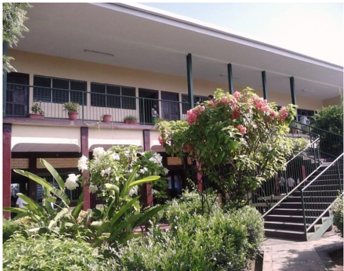
Instalaciones del Colegio Liceo Franciscano Managua.
