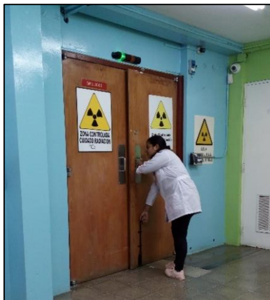
Figura 21. Verificación sistema de enclavamiento de la puerta.
