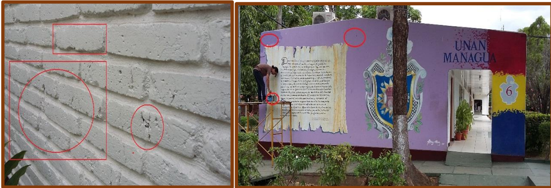
Figura 6-20. Mantenimiento correctivo superficial de las edificaciones.
