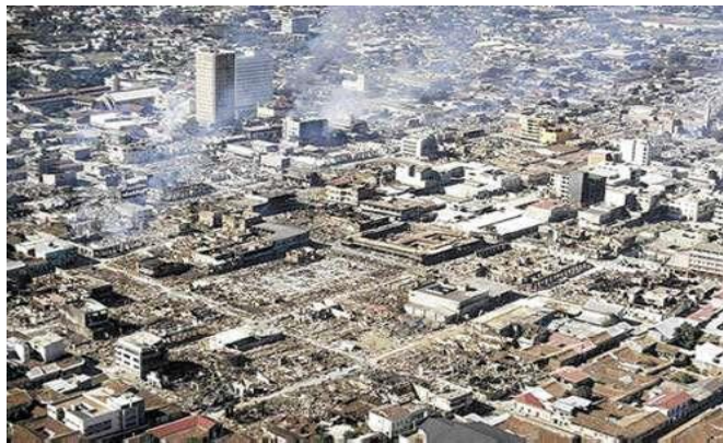
Figura 3-11. Vista aérea del centro de Managua después del terremoto de 1972. (Steinbrugge, 1972)
