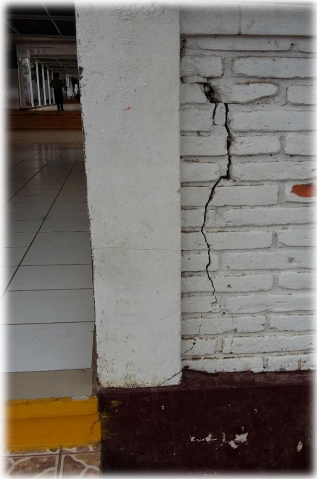
Anexo 32. Fallas en las edificaciones que muestran las Vulnerabilidad en elementos estructurales donde pueden fallar por causas sísmicas.
