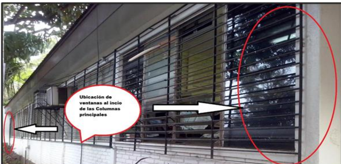
Figura 6-17. Particularidad en las puertas y ventanas.
