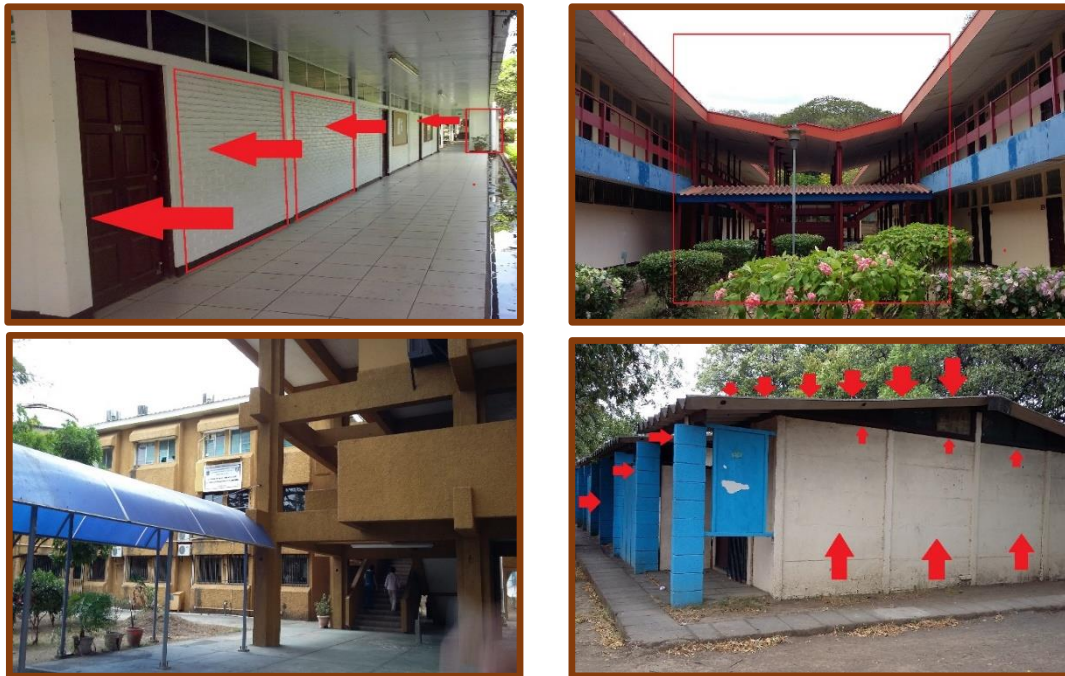
Figura 6-12. Diferentes tipologías constructivas encontradas en el área de estudio. Mampostería confinada, estructuras de acero livianas, mampostería reforzada y losas prefabricadas.
