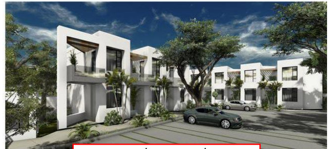
Imagen 41 / Parqueo / Fuente: Imágenes de Construcciones S.A
