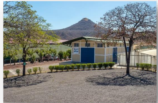
Imagen 6 Instalaciones de Procesos Fuente: Manual de BPM de Ritter Sport
