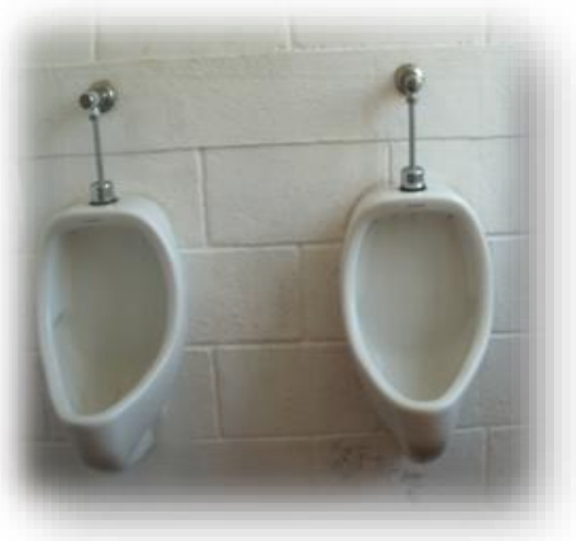
Imagen 15 Instalaciones Sanitarias Fuente: Manual de BPM de Ritter Sport
