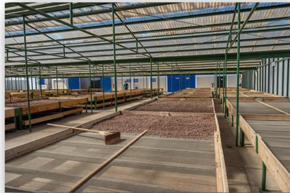
Imagen 11 Techo de Túnel de Secado Fuente: Manual de BPM de Ritter Sport
