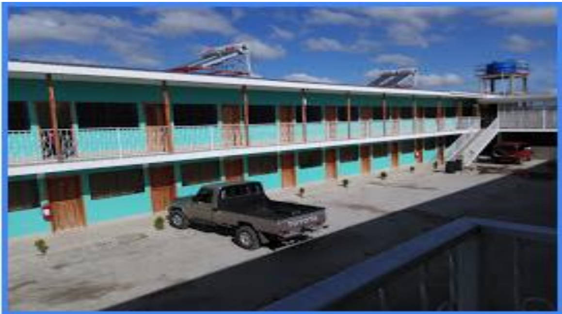
Fotografía 7. Instalaciones internas del Hotel Quiabuc
