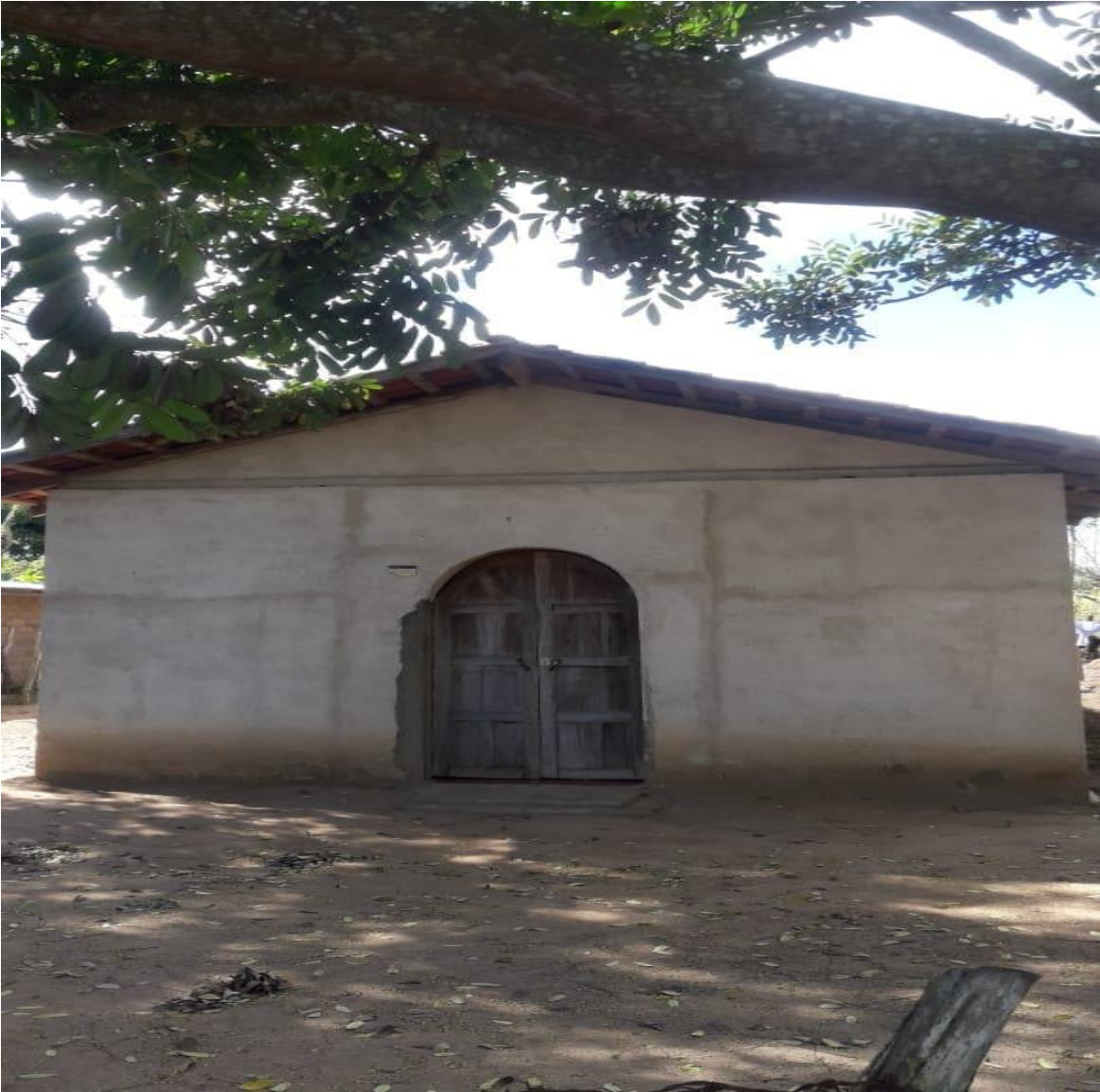
Fotografía 8 Iglesia de Restauración Cristiana N°2 seguidores de William Brahma
