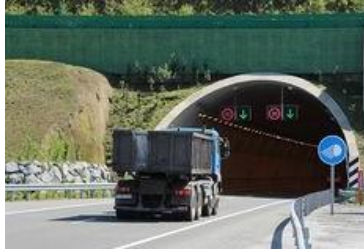
Ilustración 10. Túnel de una carretera
