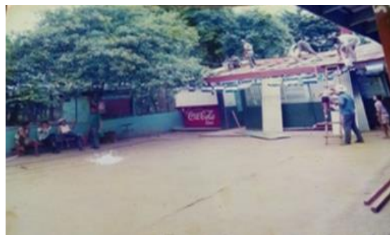
Figura 8. Pobladores colaboran en la construcción del colegio
