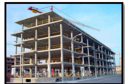
Vigas de Pilares
