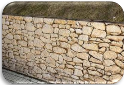
Mampostería en Piedra
