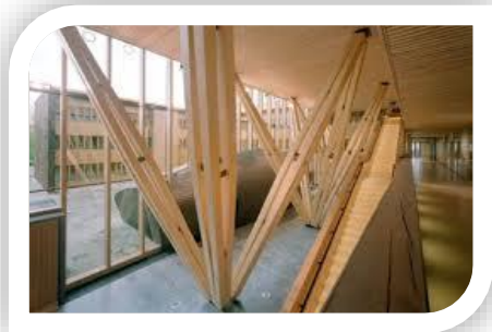
Vigas de Caja
