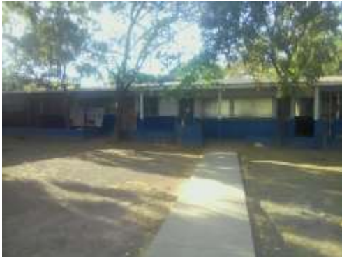
Pasillo de tercer grado.
