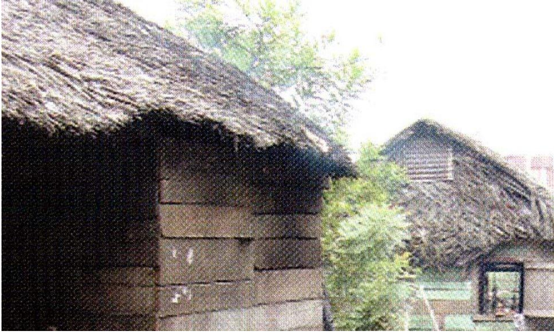
Ilustración 35 ejemplo habitacional y de materiales con las que se construye en área Rural
