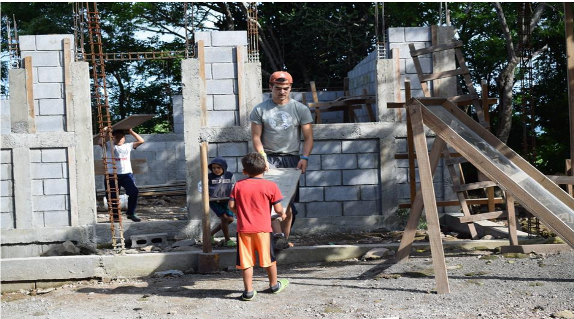
Figura 6: Construcción del Centro de Aprendizaje de Mesas de Acicaya.
