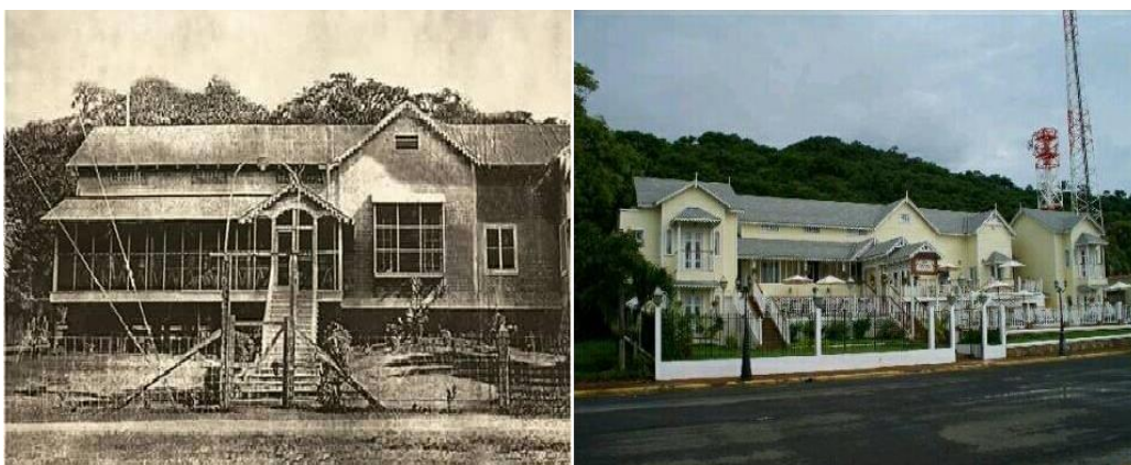
A la izquierda inicios de la infraestructura del Hotel Victoriano, a la derecha estado actual del Hotel
