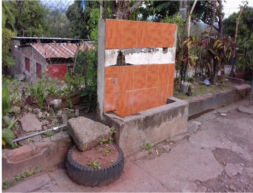
Servicios de aguas potables.
