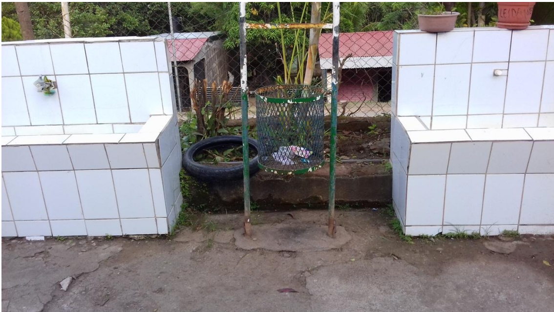
Servicios de aguas potables.
