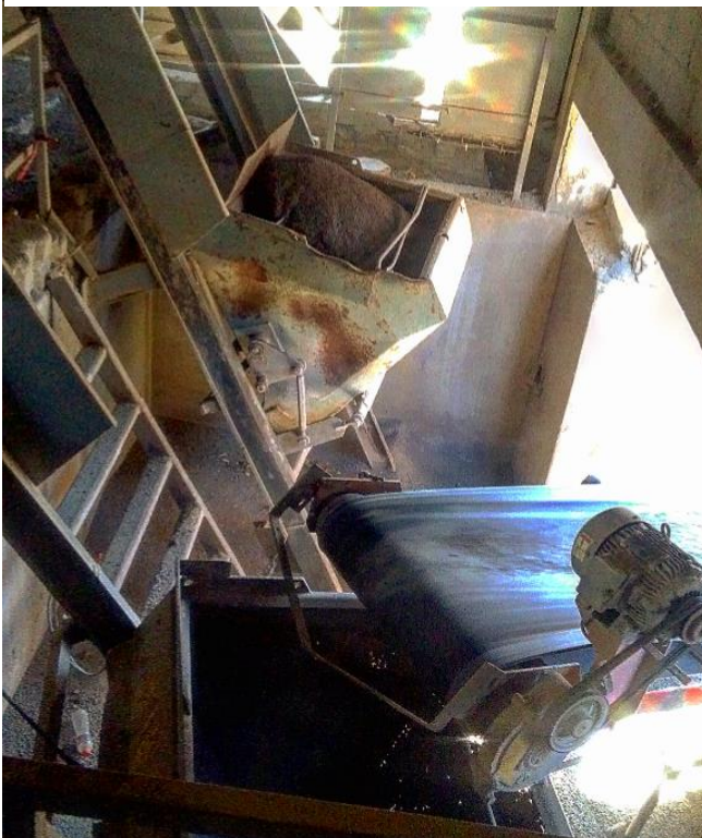
Ilustración 9. Skip para transportar los agregados de la mezcla
