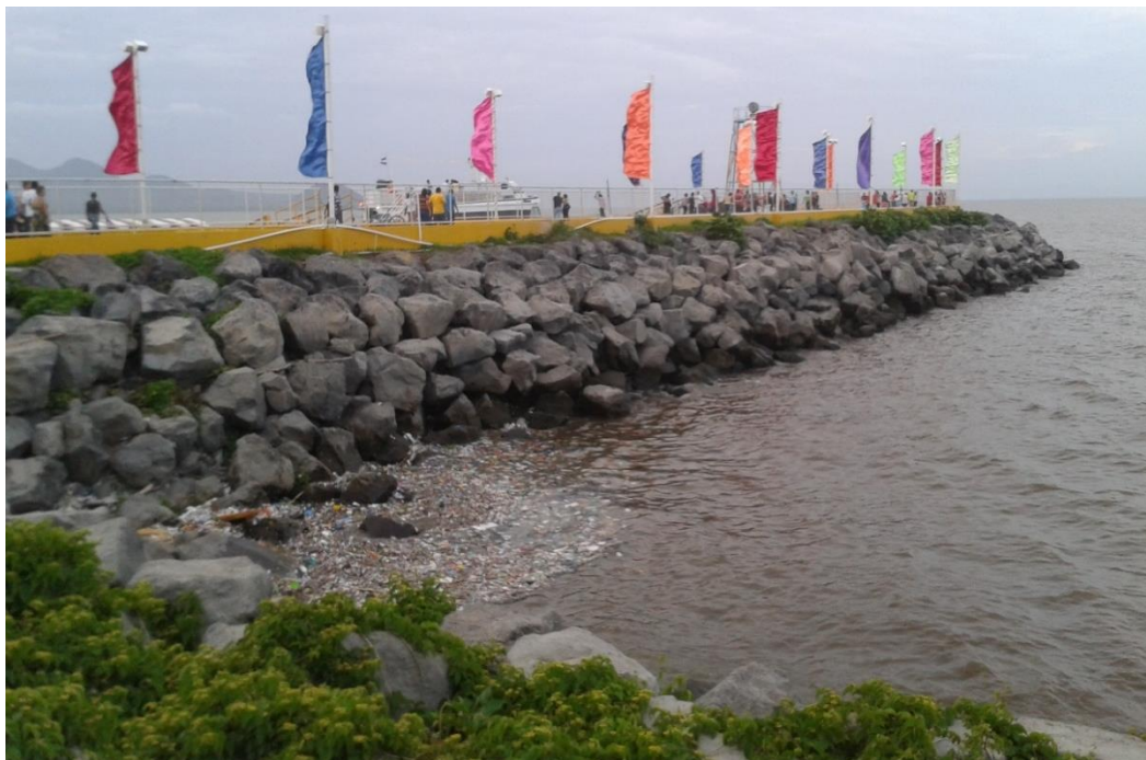
Imagen 44 Vista al muelle. Fuente propia
