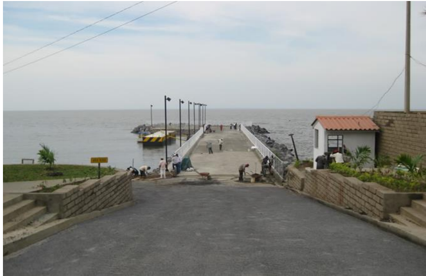
Imagen 7 Primeros Avances del proyecto de construcción de la primera etapa del puerto. Fuente SKYSCRAPERCITY.COM
