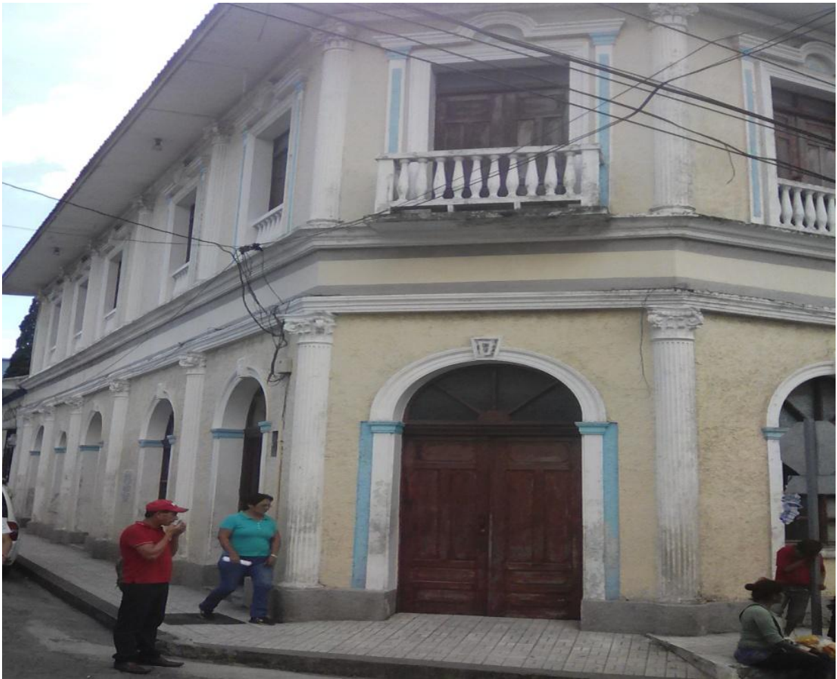
Foto de la parte exterior del edificio de la Unidad de Información 04/09/2017 ©Santos Díaz
