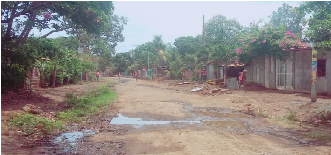
Foto 13: Proyecto de mejoramiento de aguas negras en los barrios de la Villa Bosco Monge III Etapa. Fuente: propia.
