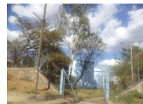
Foto. 1 Tanques de Agua
