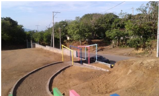
Foto 22 Nuevo acceso a la cancha comunal. Fuente propia 2016
