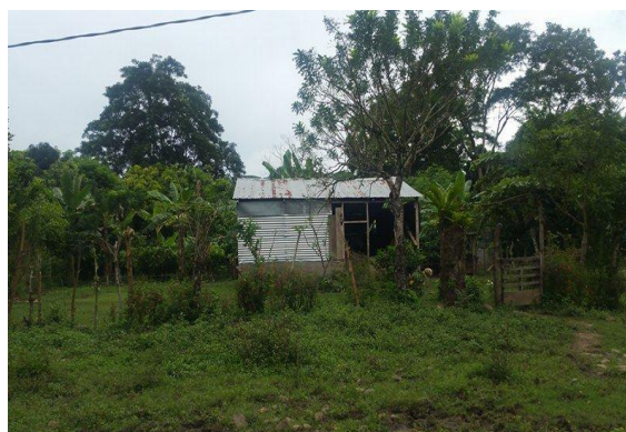
Ilustración 12 Vivienda de Colón, elaborada con materiales de construcción. Fuente: Fotografía propia.
