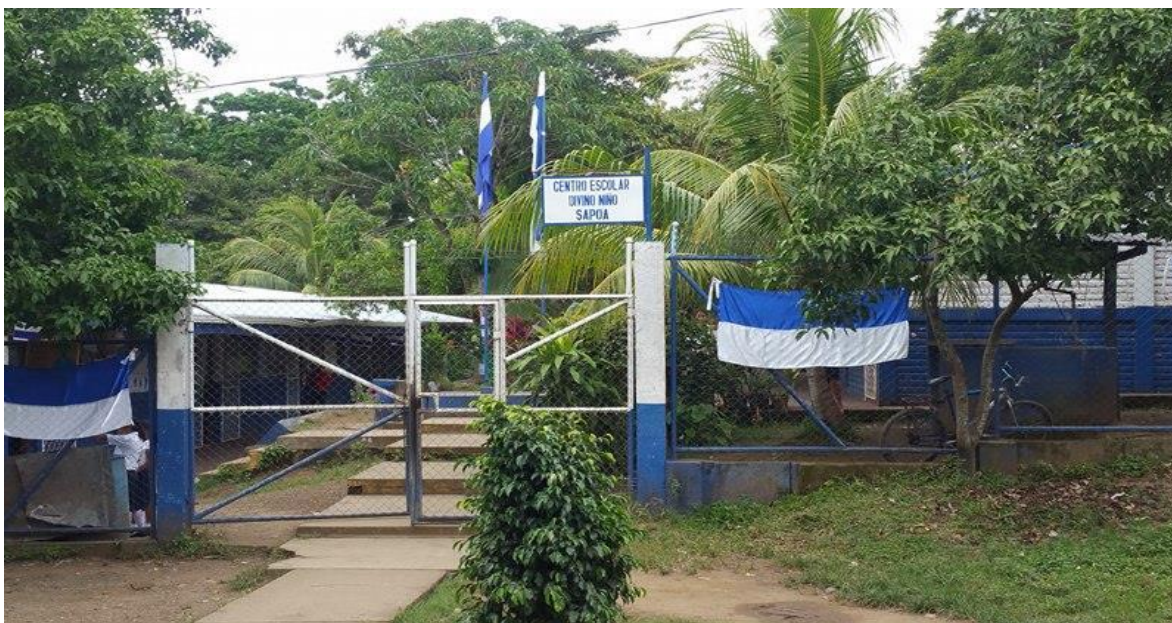
Ilustración 18 Colegio Divino Niño de Sapoá, ubicado en carretera panamericana. Fuente: Fotografía propia.
