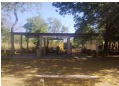
Imagen 45: Estructura arquitectónica en proceso de construcción de lo que será sala de exposición cultural en la Reserva Rancho Guadalupe. Fuente: Christopher Gago
