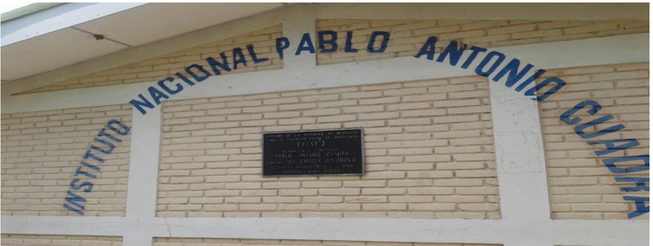
Foto 2: Estructura del centro escolar.
