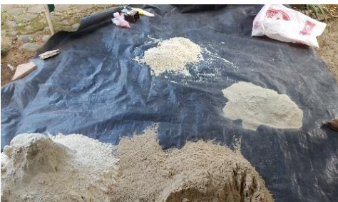
Foto 6. Mezcla de grasa sobrepasante.
