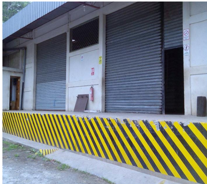
Imagen 4. Área de carga (Fuente Propia)
