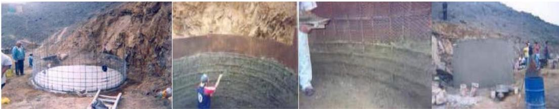
Figura 16. Elaboración de tanque a base de ferrocemento, colocación de la malla y concreto para el tanque. Fuente: Centro Panamericano de Ingeniería Sanitaria y Ciencias del Ambiente.
