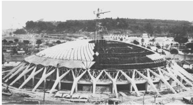
Figura 2. Palazzetto de deportes de roma – Etapa de montaje. Fuente: Conceptos generales de ferrocemento.
