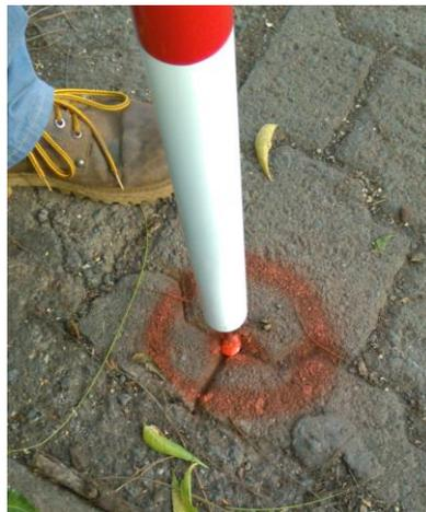
En cada uno de los puntos se colocaron chapas o mojones, los cuales fueron embazado con concreto compuesto de cemento y piedrín, con un ancho 15 centímetro por 30 centímetro de profundidad. A este mojón geodésico en la parte inferior trae un orificio el cual se le coloca un clavo de 4 pulgada traspasando el orificio para cuando este sea embazado le dé mayor seguridad a la chapa o mojón geodésico.
