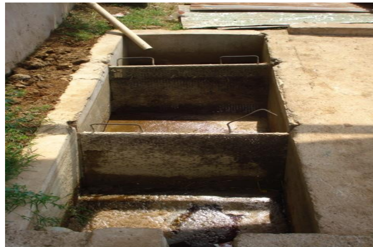
Anexo 29: Área de Recepción de los desechos líquidos
