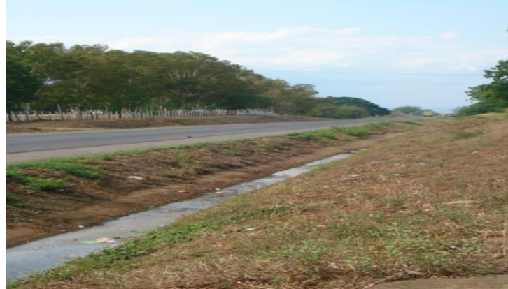
Anexo 30: Canal de desagüe
