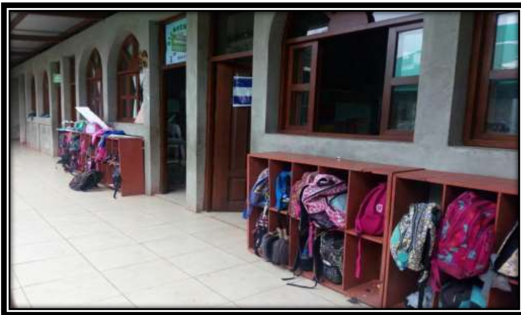
Foto # 2 Pabellón de Primaria
