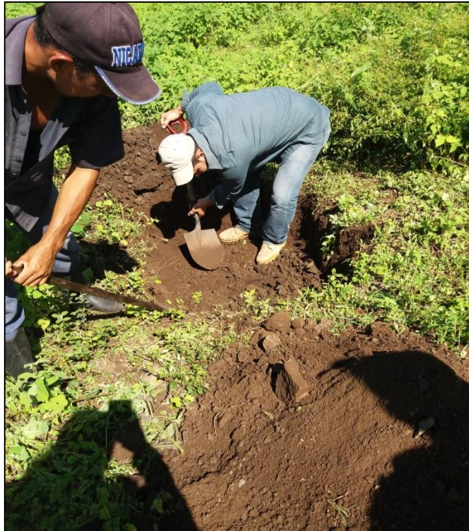
Foto 3. Excavación de calicata en los sitios de estudio.
