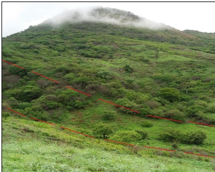
Foto 20. Zona de fallamiento con plano marcado en falda de Loma la Mestiza comunidad de la Grecia. Coordenadas E 548900 N 1455755.
