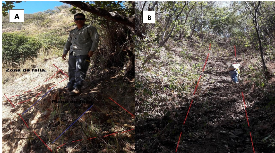
Foto 28. A) Corte aflorante donde se observa un plano de falla marcado junto con un sistema de fracturas paralelas sobre la misma falla normal. Coordenadas E 552902 N 1462250. B) Presencia de falla de con desplazamiento vertical normal. Sector El Jicarito – Loma Tierra Blanca. Coordenadas E 553100 N 1463000.
