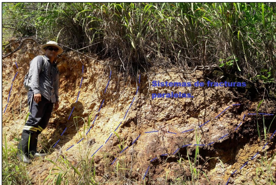
Foto 26. Corte aflorante litológicamente compuesto de riolitas observándose un sistema de fracturas paralelas. Se ubica entre El Ocotillo y Colocondo. Coordenadas E 554798 N 1462288.
