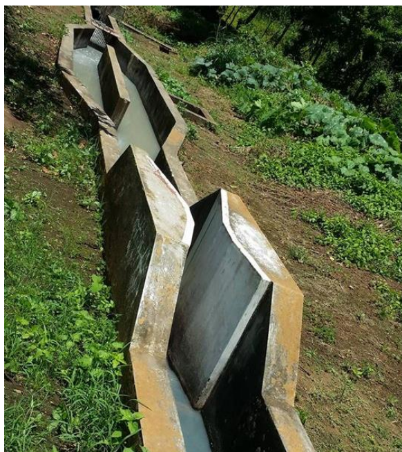
Foto 9: Sistema de pre-tratamiento para aguas residuales compuesto por una rejilla, un desarenador y dos canales Parshall; los dos canales son utilizados como dispositivo de medición de flujos.
