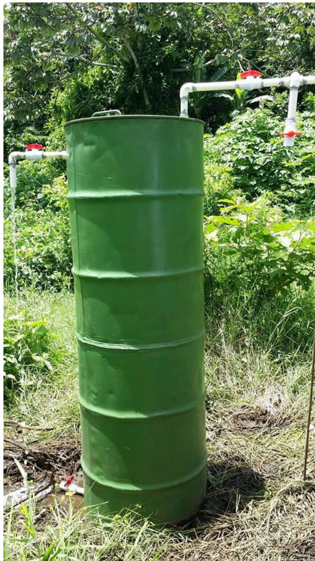
Foto. 1: Implementación de filtro rocoso en PTAR-Masatepe. Fuente: Elaboración propia, 2016.
