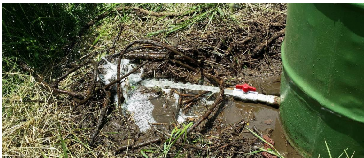
Foto. 2: sistema de mantenimiento y limpieza del filtro rocoso, implementado en PTAR-Masatepe.
