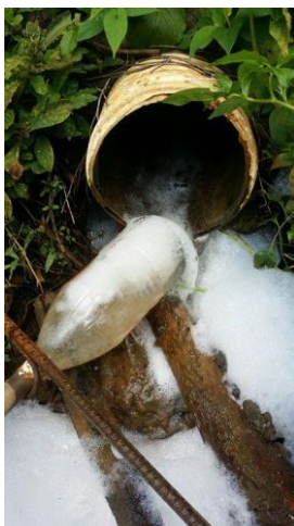
Foto 9: Captación de aguas residuales. Fuente: Elaboración propia, 2016.
