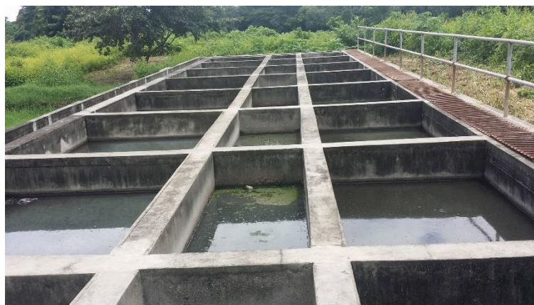
Foto 10: Tratamiento primario en Tanques Imhoff; produce sedimentación de sólidos en la parte superior y digestión de los sólidos sedimentales en el nivel inferior.
