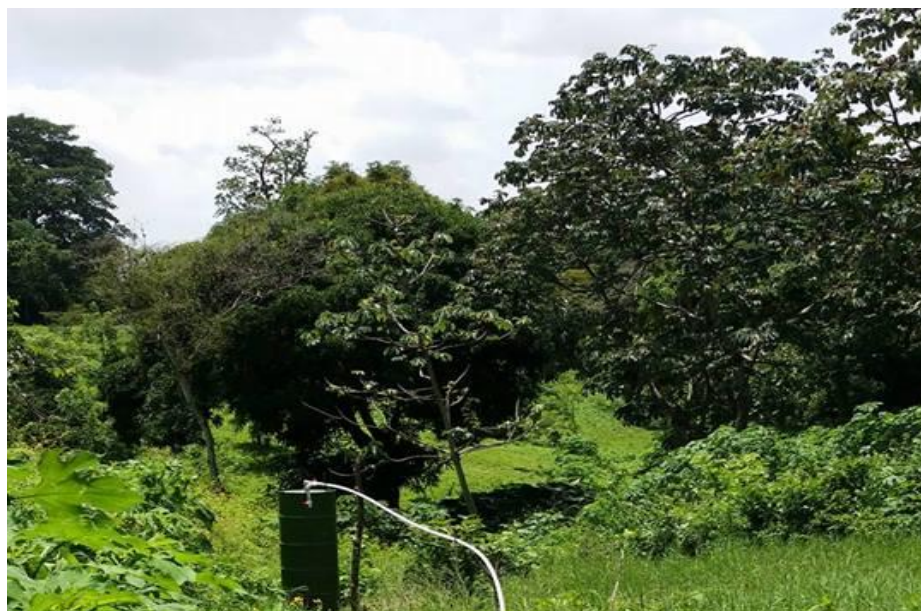
Foto. 3: Filtro rocoso en operación, planta de tratamiento de Masatepe.
