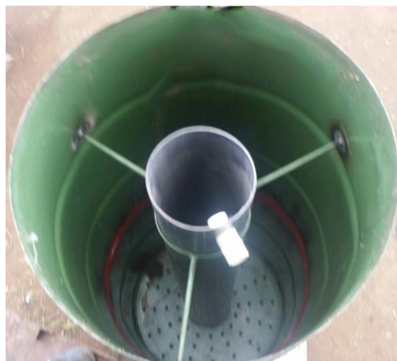
Foto 14: filtro rocoso sin material filtrante.
