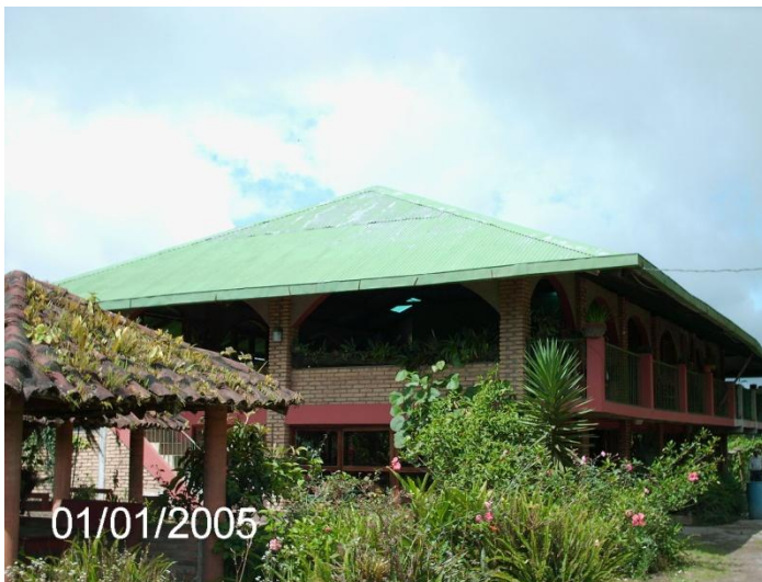
Estructura del Restaurante
