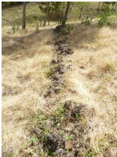
Fotografía 2. Parcela Sidar Sánchez (Barreras Muertas de piedras)
