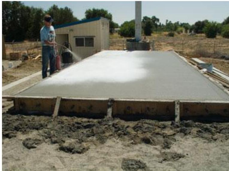
Figura 21. Aplicación de Membrana de Curado. Fuente: Elaboración Propia.
