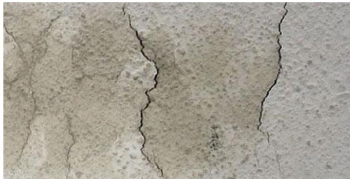
Figura 20. Agrietamiento por Contracción del Concreto. Fuente ACI.
