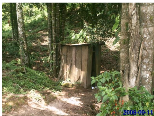
Foto N° 6, Letrinas en muy buen estado
