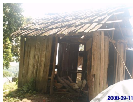
Foto N° 10, Almacén deteriorado por el tiempo
