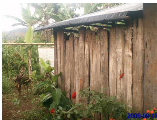
Foto N° 7, Letrinas en mal estado
