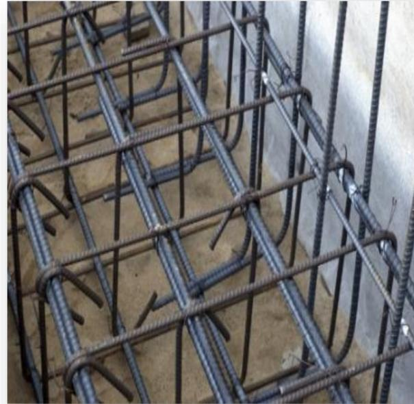
Imagen 35; Armado de las varillas.
