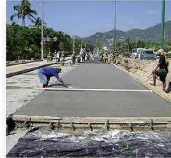
Imagen 45; Concreto hidráulico.
