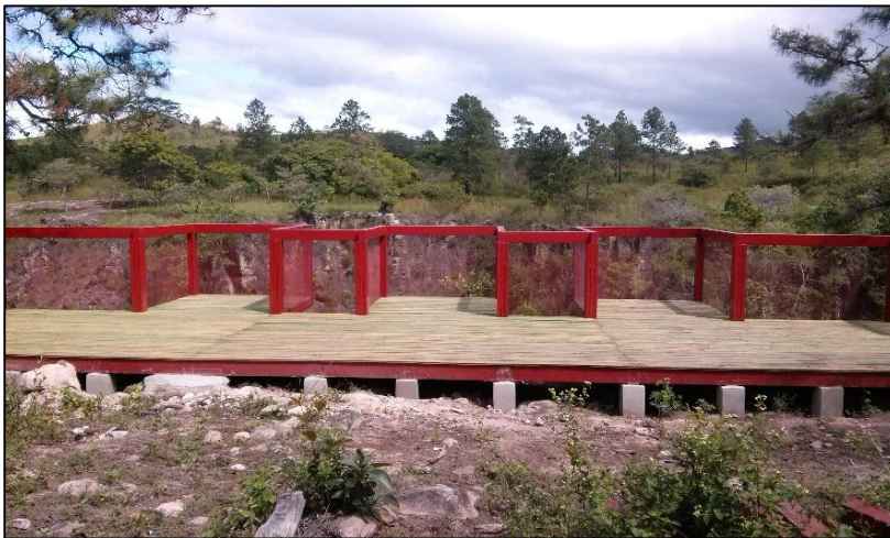
Fuente propia: Construcción del Mirador Cañón Seco
