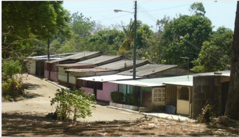
Imagen 31. En la imagen se muestra el tendido de alta tensión de la colonia MINVAH. Fuente: propia.
