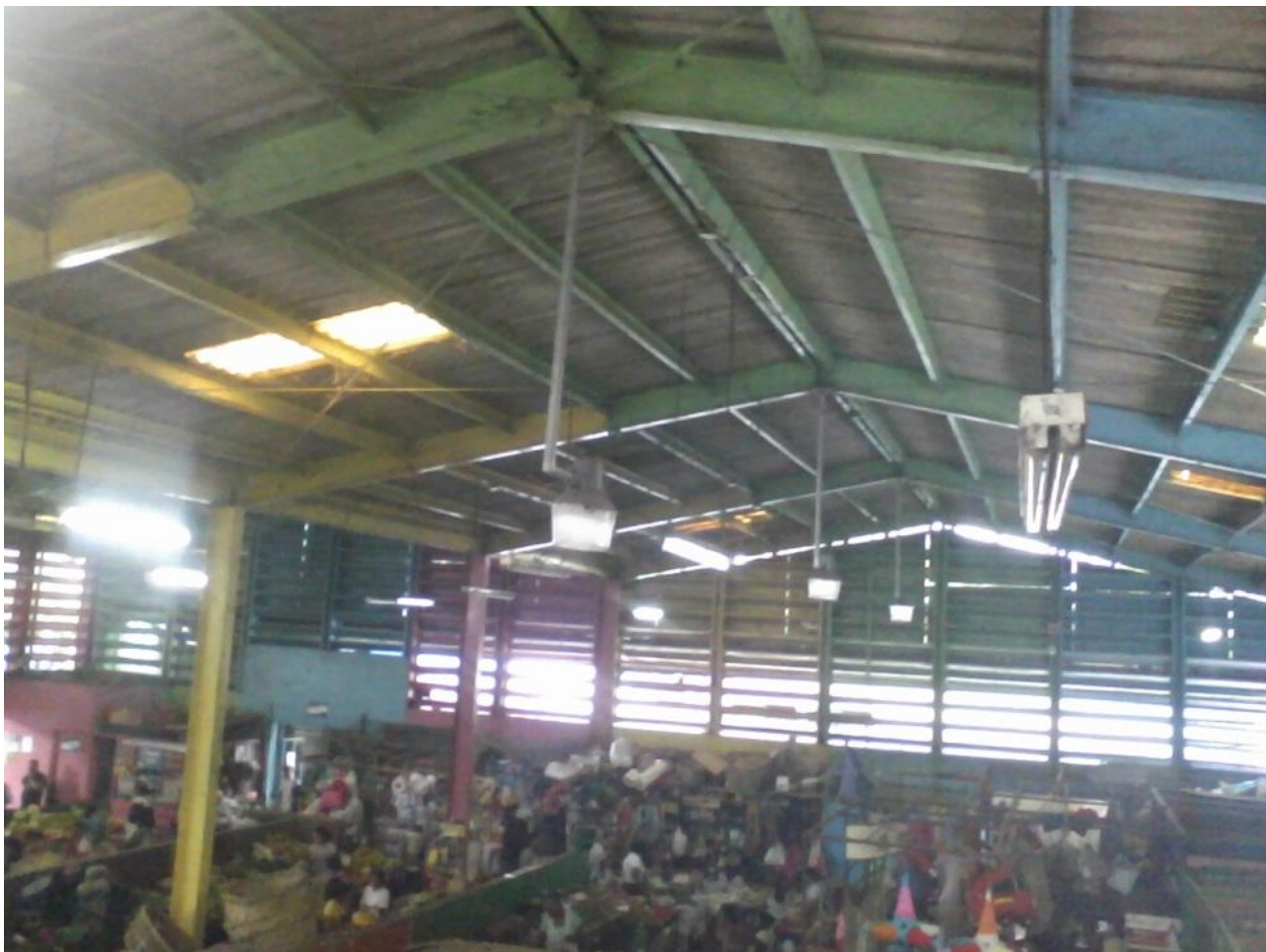
Imagen No 18 .Imagen de la estructura de techo del Mercado .Fuente (Propia)
