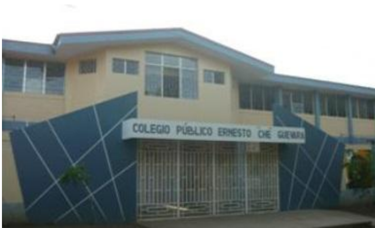
Imagen No34. Imagen de equipamiento urbano existente en el municipio (Colegio Público "Che" Guevara). Fuente: propia
