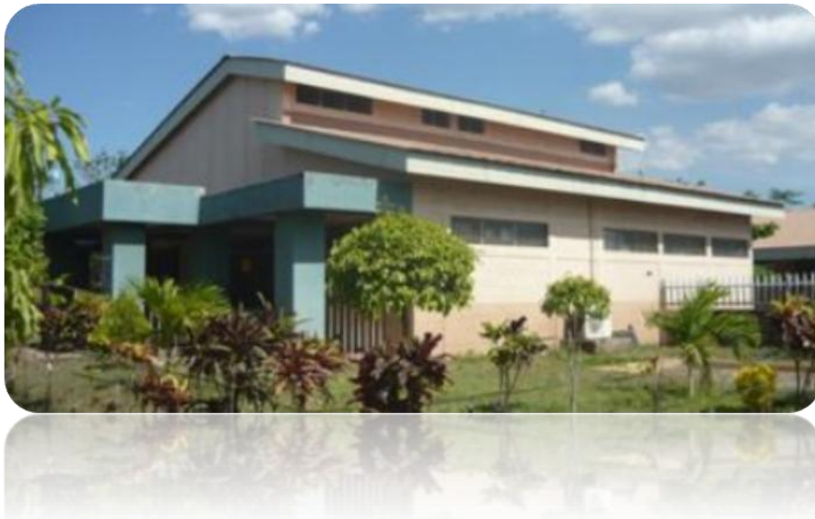
Imagen No 33.Vista exterior del Centro de Salud de Villa el Carmen .Fuente: Propia
