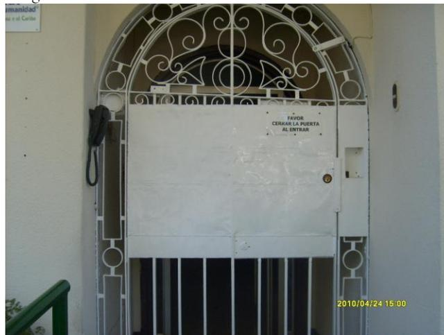
**Figura 14.23.** Seguridad Física/ Control de Acceso del Personal a las Instalaciones desde Recepción – Puerta Eléctrica
